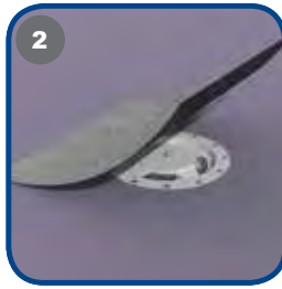
2 Sentrer slukmansjetten over sluket, og monter den.
