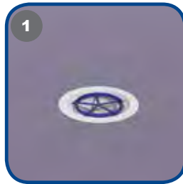
1 Sentrer slukmansjetten over sluket, og monter den. Gni mansjetten godt fast. Kontroller at det ikke blir blemmer eller folder.
