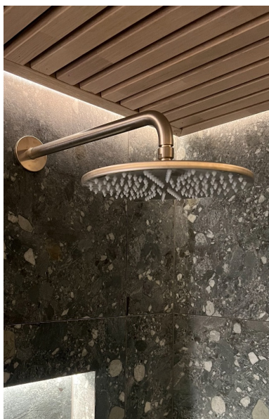
Bygget og installert av @madspusseropp
