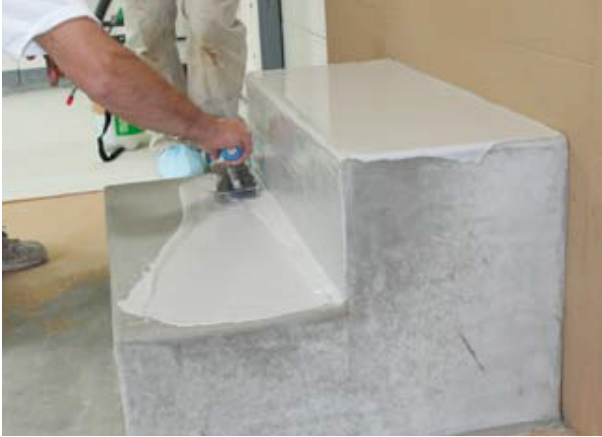
På trapp helles en liten mengde på det øverste trinnet. La overflødig masse renne ned på sidene.
