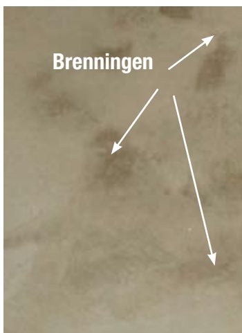
Med disse to verktøyene «brennes» betongen som vist til venstre (marmoreringer). Man kan også få en mer ensartet overflate som på bildet til høyre.
