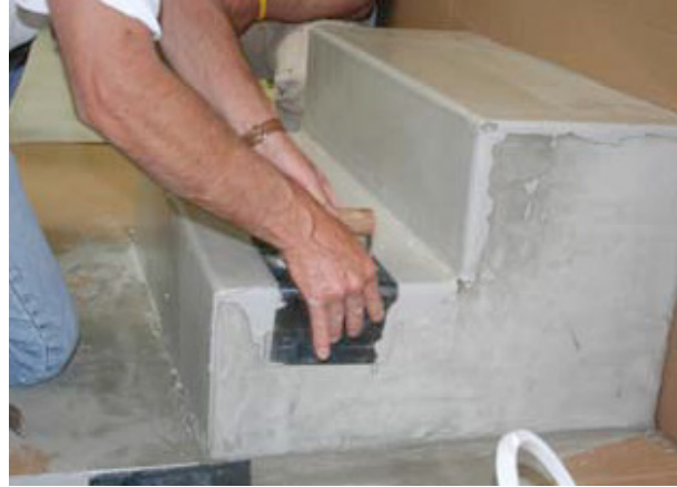
Bruk et pussebrett for utvendig vinkel til å avrunde trappenesen. Man kan også bruke lokket til en plastbøtte, og bøye det i ønsket vinkel. Bruk den omvendte vinkelen for inntrinnet.
