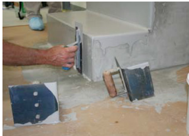
Glatt ut dråper på de loddrette partiene før de tørker. Det vil bli en linje ved trappenesen og inntrinnet; denne vil forsvinne ved pussing med korn 120 når den er tørr.
