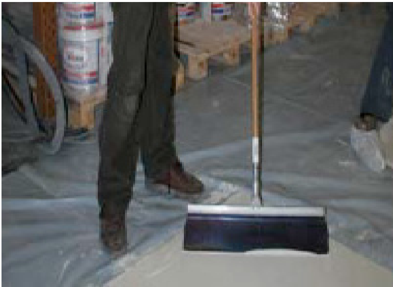
I likhet med NivO`grip kan Finiton-pulveret påføres med en gulvskrape med skaft...
