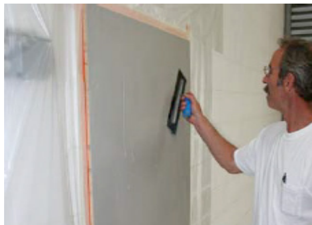
Glatt ut. Lakker trappene og veggen. Det er ikke nødvendig å vokse veggene.
