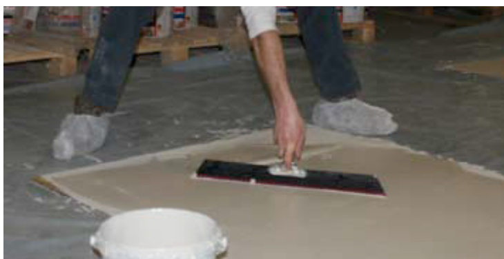
For å ikke, eller nesten ikke, «brenne», kan man bruke en myk beleggutglatter. Ettersom det påførte trykket er mindre, øker forbruket (se tabellen til høyre).
