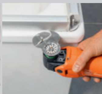
Elastisk tetningsmasse løses perfekt før ny fugging.
