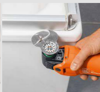
Elastisk tetningsmasse løses perfekt før ny fugging.
