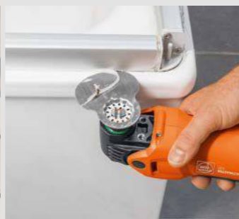
Elastisk tetningsmasse løses perfekt før ny fugging.
