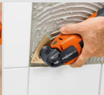
Hardmetallraspen jevner ut fliselimet og sørger for et plant underlag.
